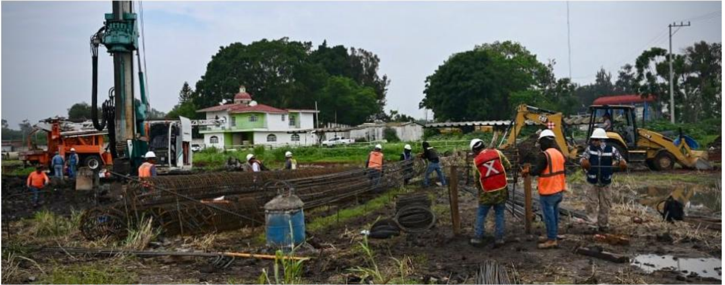
Realizan obras en la planta potabilizadora número 5 y el colector Villa Fontana. CORTESÍA: GOBIERNO DE JALISCO
