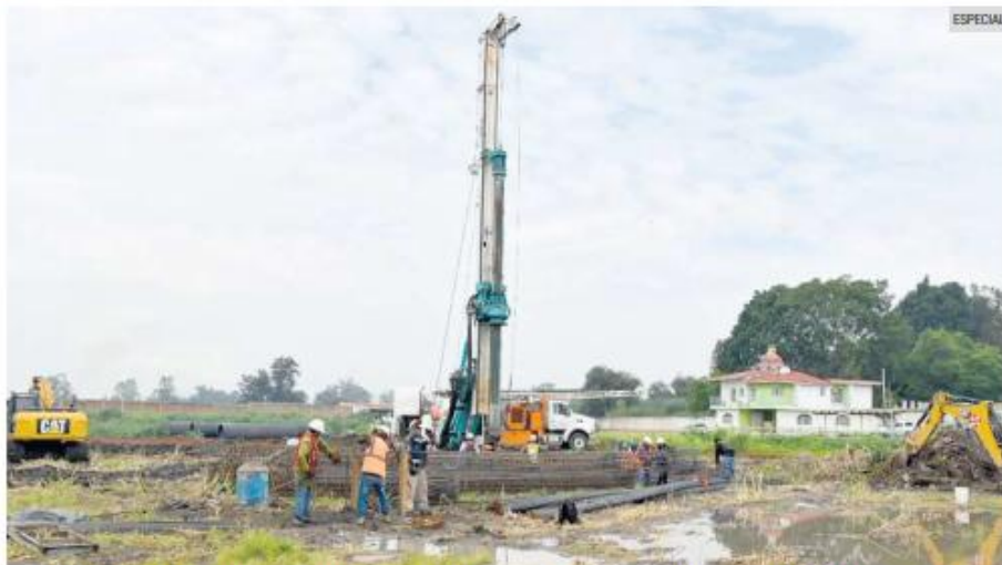
ACCIONES. El Gobierno de Jalisco prevé destinar recursos estatales para concluir las obras hidráulicas de La Calera, ante la falta de financiamiento federal.
