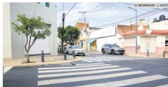
RENOVACIÓN. Parte de las obras se enfocaron en delimitar los pasos seguros en las principales vialidades del barrio.
