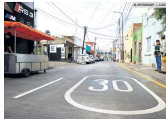
MODERNIZACIÓN. Se renovaron las vialidades, que además de tener concreto hidráulico, también cuentan con nueva infraestructura hídrica.
