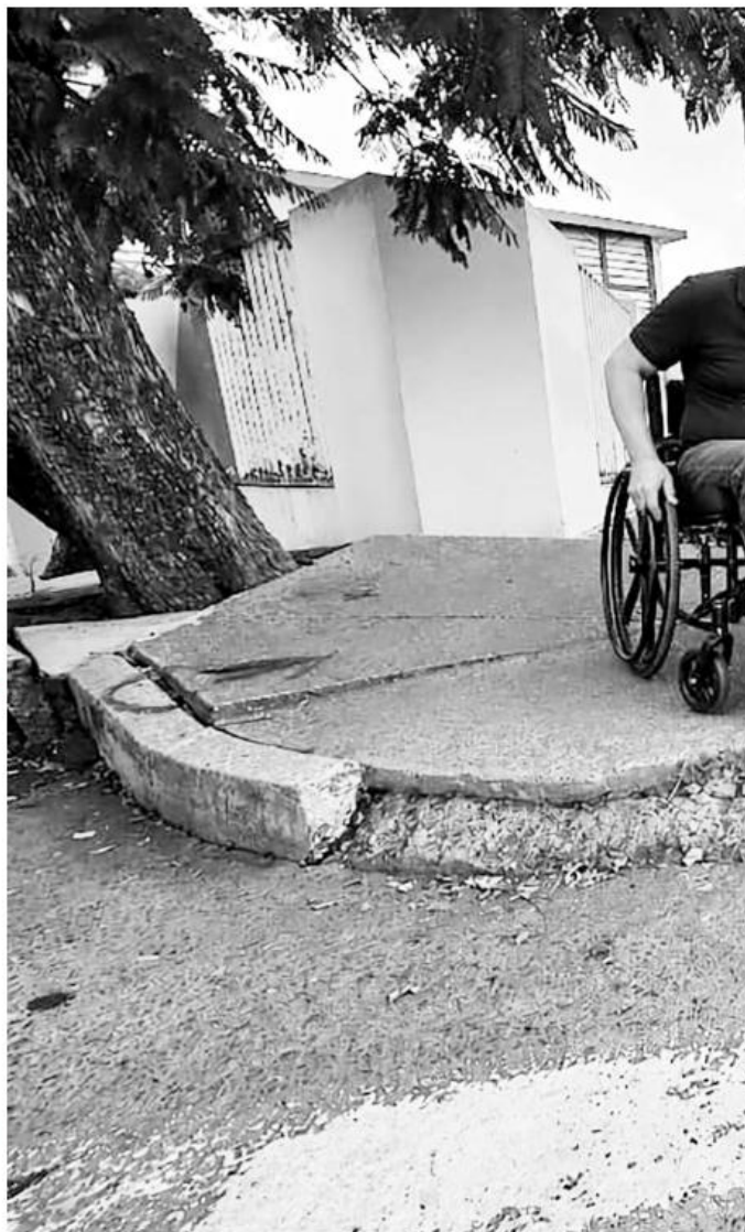
Una ciudad incluyente requiere señalización para personas con discapacidad visual y auditiva, infraestructura adecuada para distintos tipos de discapacidad.
