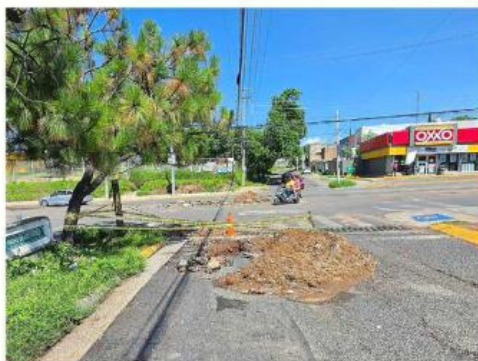
■ Atienden una falla en la red sanitaria.
