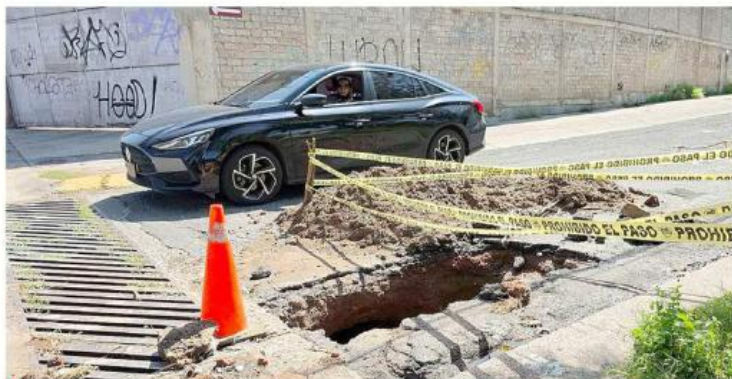
■ Para reparar la fuga, las autoridades realizaron dos excavaciones en la zona: una, sobre Paseos de los Patios y otra en Camino Real de Colima.
