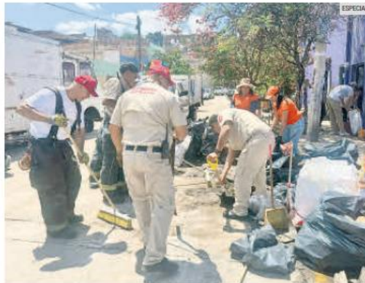
LIMPIEZA. Cuadrillas municipales retiraron lodo, desechos y escombros para restablecer las condiciones de seguridad en las calles afectadas.
