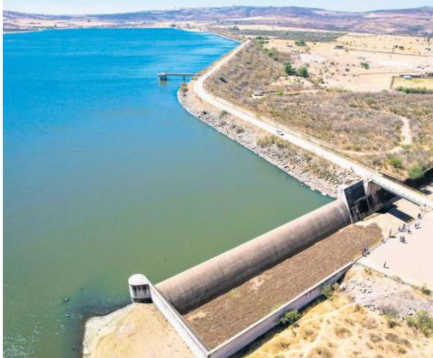
TRABAJOS. Las reparaciones del acueducto y las pruebas hidráulicas están bajo la supervisión de la CONAGUA.
