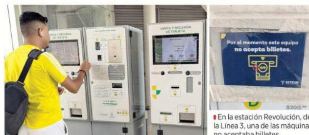
Los elevadores han sido una de las fallas del sistema. Ayer, en la estación Ávila Camacho, uno estaba fuera de servicio.
