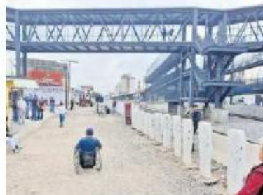
OBRA. El acceso peatonal a Las Juntas fue rehabilitado.
