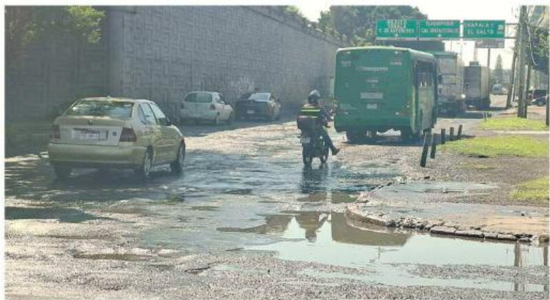
El agua estancada impide medir la profundidad de los hoyancos; esto daña llantas y suspensiones.
