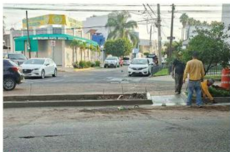
■ El camellón de Avenida Conchita, a su cruce con la Calle Quebrada, se amplió buscando evitar accidentes en la zona.
