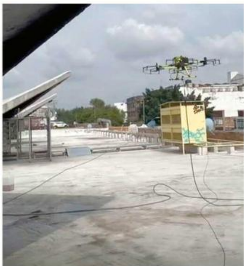
Se utilizarán drones para la limpieza de los techos del Mercado San Juan de Dios. Accederán a las zonas de mayor altura y complejidad técnica.
