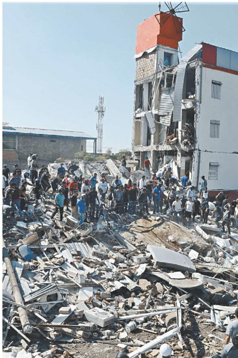
Trabajos de rescate en uno de los 20 edificios que colapsaron en Cali. ERNESTO GUZMÁN/EFE
