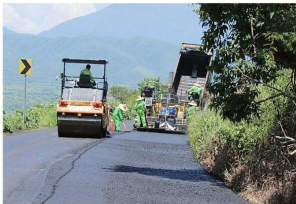
■ Parte de las reparaciones de la Carretera Libre a Vallarta se ejecutan en el municipio de Ameca.
