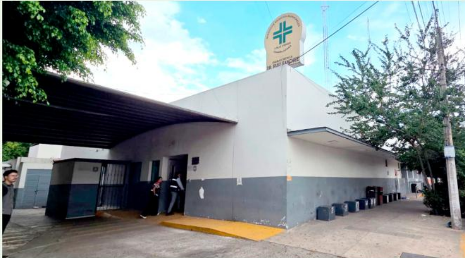
No habrá cierres de calles; solo se instalará un tapial de protección y señalización de camiones.
