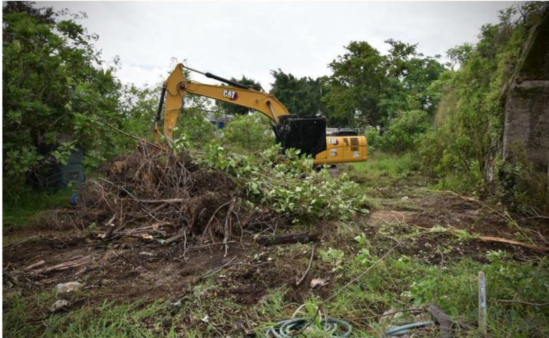
En julio arrancaron los trabajos del nuevo tren de potabilización en la Planta Potabilizadora No. 1. CORTESÍA: GOBIERNO DE JALISCO
