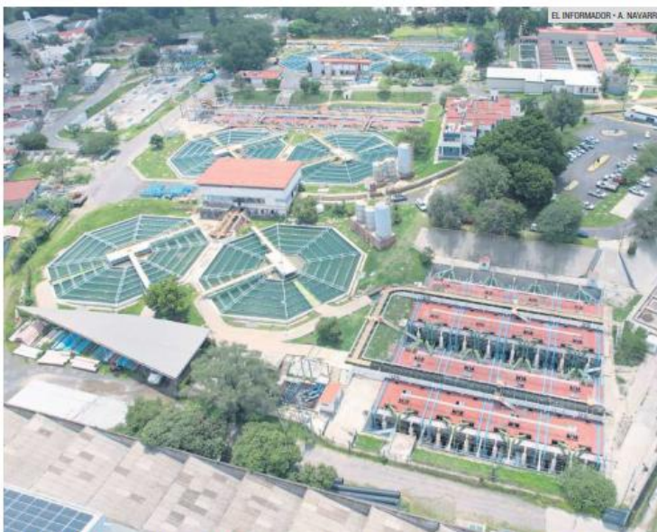
PRIORIDAD. La Planta Potabilizadora Número 1 de Miravalle forma parte de los proyectos que Jalisco busca modernizar con respaldo federal.
