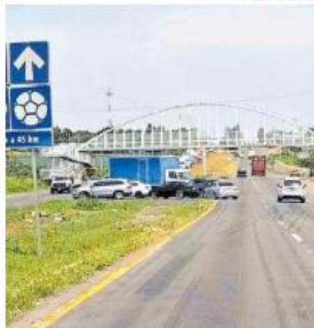
OBRA. La carretera a Chapala sufre de mucho tráfico en ciertas zonas.
