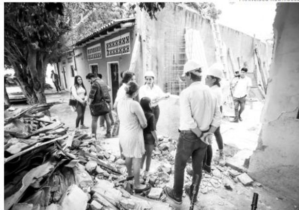
Sismos han provocado daños como en el vecino estado de Colima.
