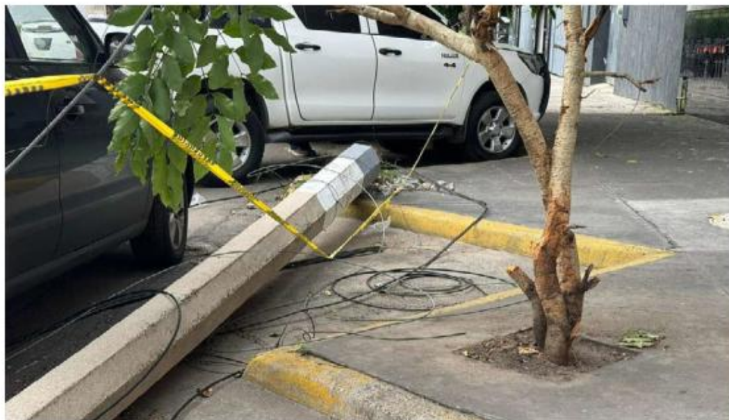
Los cables en desuso representan un peligro en la vía pública. TONY MARTÍNEZ
