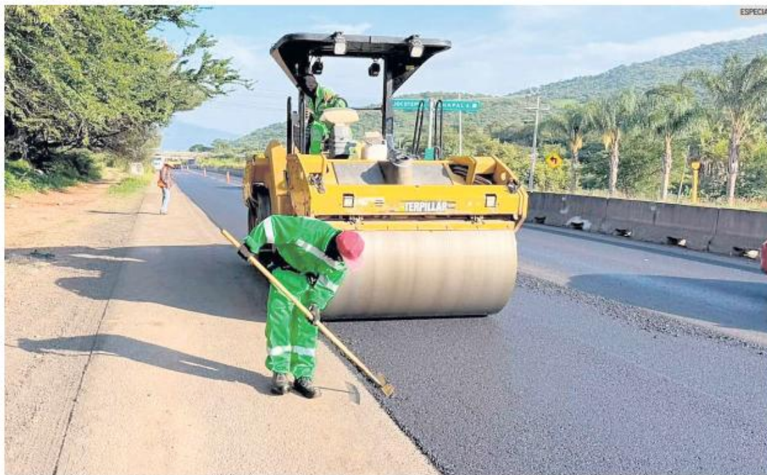
CARRETERAS. Trabajos de pavimentación y personal operativo en las vialidades federales del estado de Jalisco.
