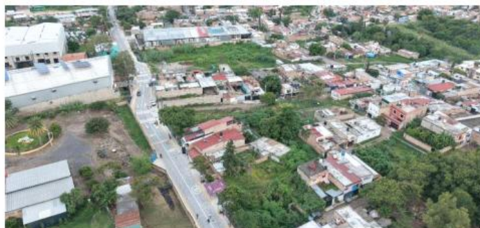
La obra abarcó desde la sustitución de redes sanitarias hasta la pavimentación de vialidades.
