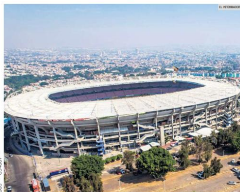
PROYECTO. El Estadio Jalisco inicia una nueva etapa de renovación con obras para mejorar su cancha, servicios, seguridad e infraestructura, de cara a más partidos y espectáculos.
