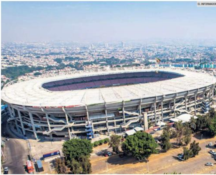
PROYECTO. El Estadio Jalisco inicia una nueva etapa de renovación con obras para mejorar su cancha, servicios, seguridad e infraestructura, de cara a más partidos y espectáculos.
