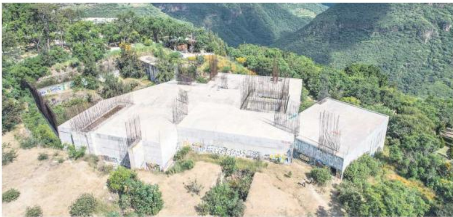
AVANCE. La construcción del Museo de la Barranca registra alrededor de 25% de avance y acumula una inversión cercana a 400 millones de pesos.
