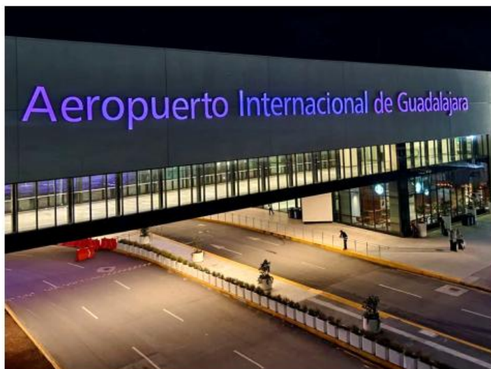
Las obras forman parte de un proyecto integral para la ampliación del aeropuerto.
