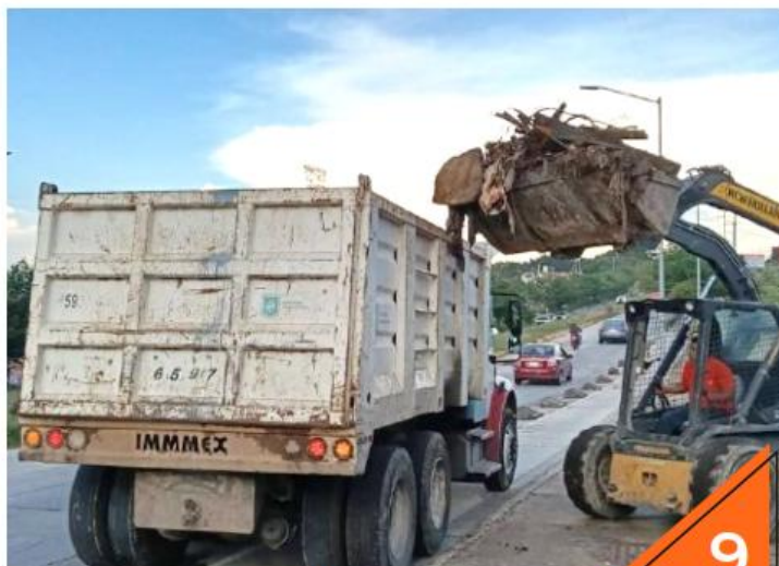
Intensificaron las labores de saneamiento.
