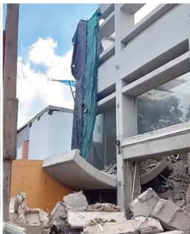
Demolición del edificio de Aceves en Manuel Acuña.
