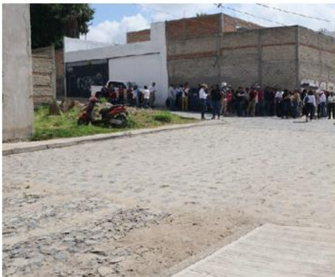
La obra fue en la calle Magnolia. ESPECIAL
