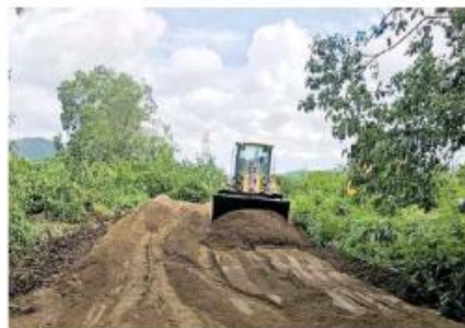
El Centro SCT Jalisco inició este viernes la construcción de un camino de desvío.
