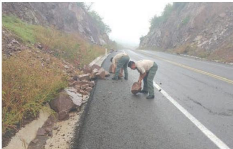
DESLAVES. En la carretera 200 se registraron deslaves y derrumbes causados por la humedad
