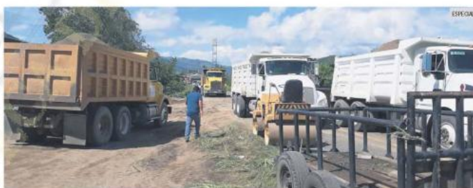
APOYO. Los módulos de A Toda Máquina trabajan en la reparación de carreteras y caminos del Sur del Estado, afectados tras el paso del huracán "Lorena".
