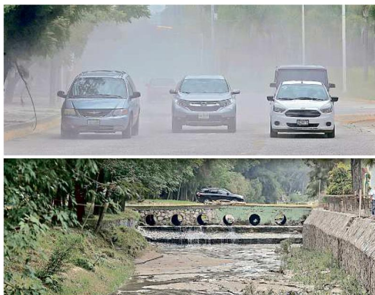
OFF ROAD ZAPOPAN. Tras el desbordamiento del canal de Patria, los carriles quedaron cubiertos de polvo. El Alcalde señaló que los tubos angostos provocaron la salida de agua.
