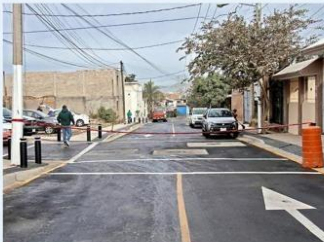
■ Zapopan entregó la pavimentación de la Calle Eucalipto.
