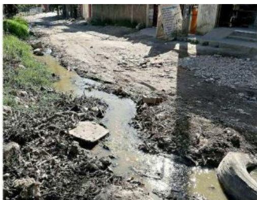
■ De acuerdo con vecinos, las aguas negras continúan corriendo por el cauce del Arroyo Seco.
