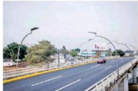
La remodelación de laterales ya está casi lista.
