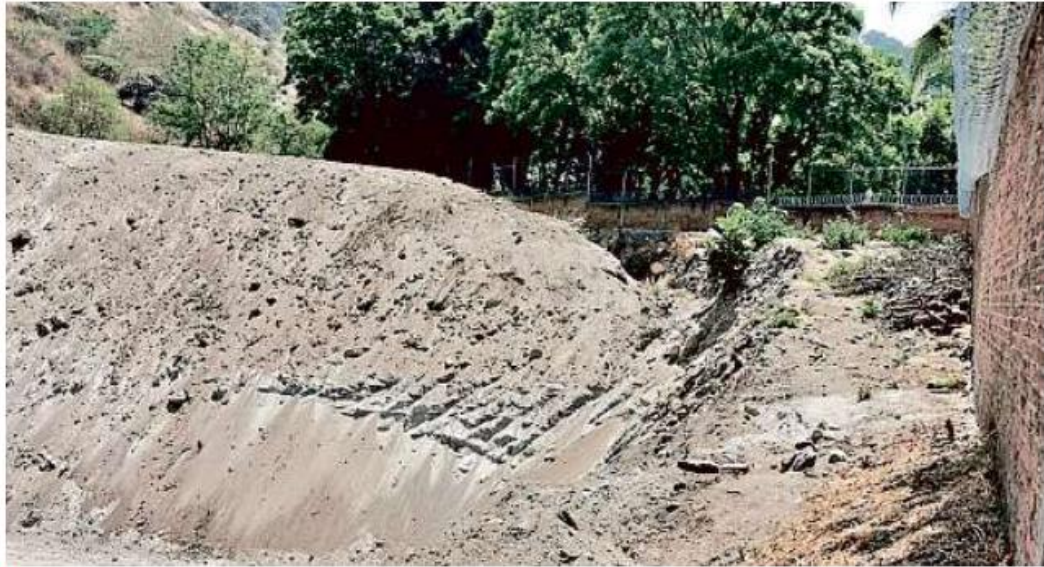
■ Dentro de un predio que les facilitó México Inversiones, el Club de Golf Santa Anita construye un vaso regulador de agua.
