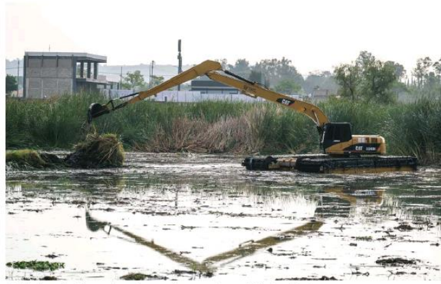
Trabajos de drenado y desazolve en el canal de Las Pintas. CORTESÍA GOBIAL.
